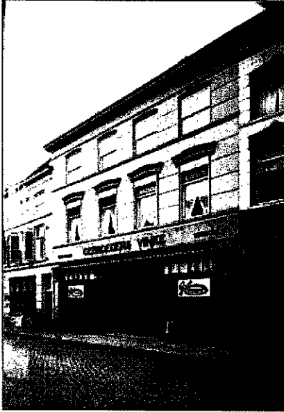
Figuur 4: De voorgevel vóór 1933
