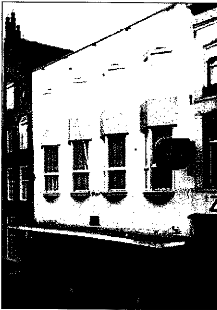
Figuur 6: De versoberde gevel in de jaren zestig
