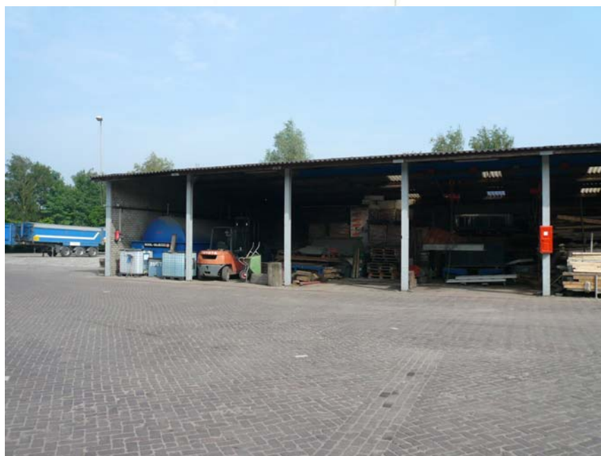
noordelijke opslagloods (helft van L-vormig gebouw)
