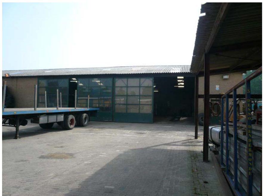
Te vervangen werkplaats (midden) en te slopen opslag (rechts)
